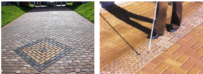
Piso intertravado e com guia tátil
